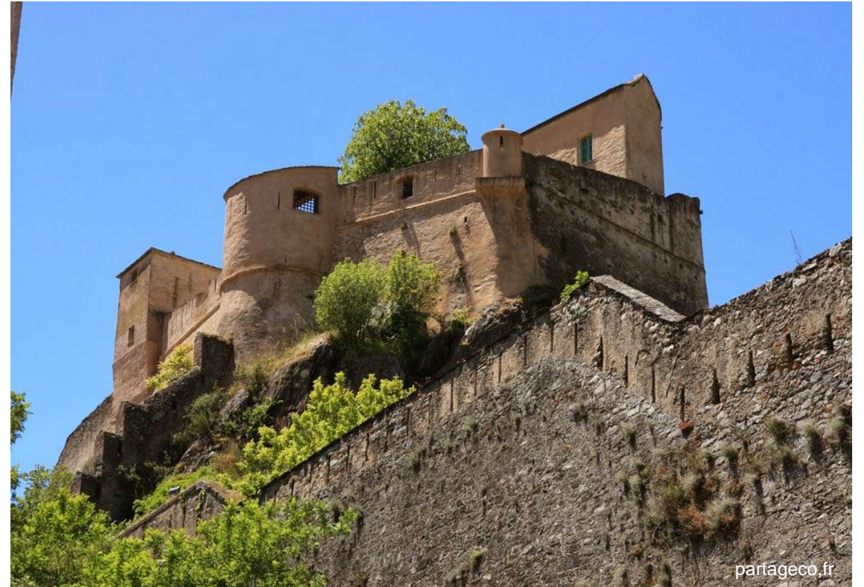
MUR D'ENCEINTE DE LA CITADELLE
